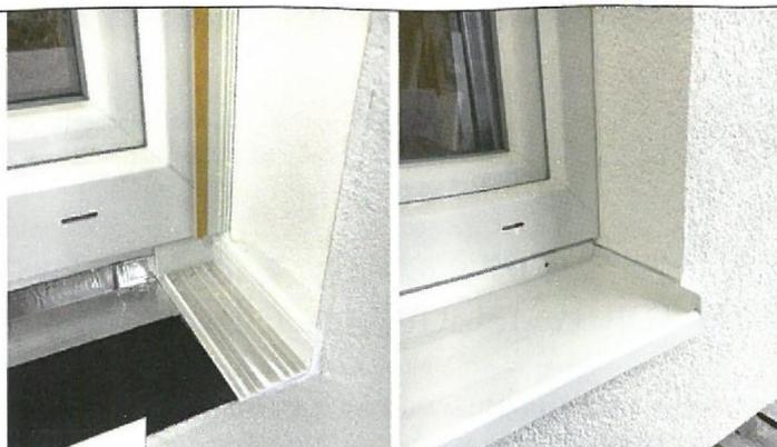
**Dank der emv-Fensterbanksysteme kann die Fensterbankabdeckung jetzt erst nach dem Auftragen des Fassadenoberputzes eingebaut werden. Durch die Konstruktion der Bordprofile lässt sie sich problemlos von oben in das System einlegen.**
