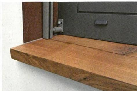
**Die Vario-PVC-Slider/Rillengleiter werden mit der Keilplatte verklebt. Diese zweite Entwässerungsebene gewährleistet sowohl einen dauerhaft dichten WDVS- als auch Mauerwerksabschluss. Mit den emv-Systemen gibt es bei Fensterbankdesign und Materialauswahl keine Grenzen mehr.**
